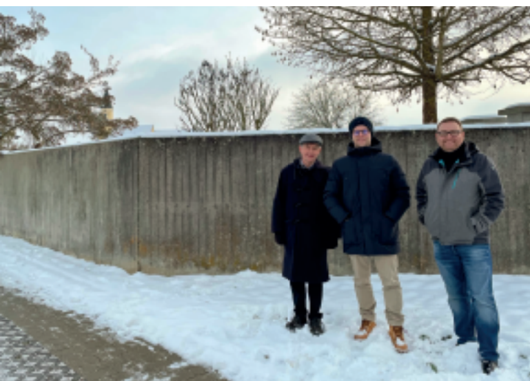
In diesem Bereich müsste lediglich die Wand durchgebrochen werden. Anschließend wären einige wenige Meter Weg notwendig. (v. l.) Albert Steber, Simon Steber, Dr. Bastian Bohn
